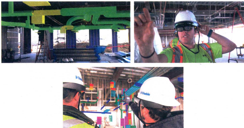
图 8.14 建筑施工 ①
